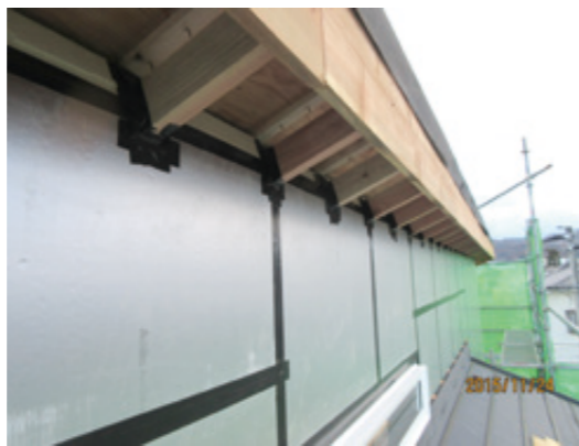
キューワンボードを使った外断熱による壁(左)と屋根の断熱(上)の施工例
