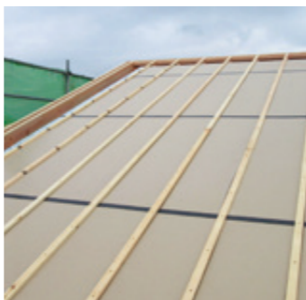
キューワンボードを使った外断熱による壁(左)と屋根の断熱(上)の施工例
